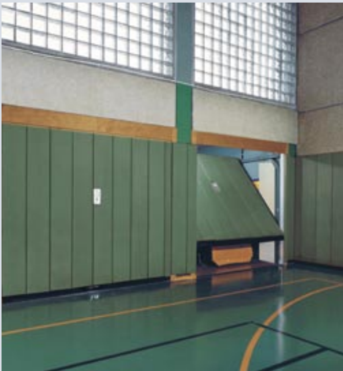
Tore mit Integralplattenauflage (Prallwand)
