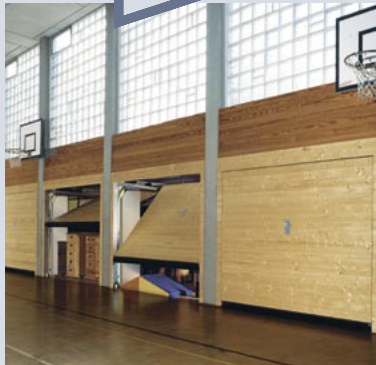
Tore mit bauseitiger Holzfüllung
