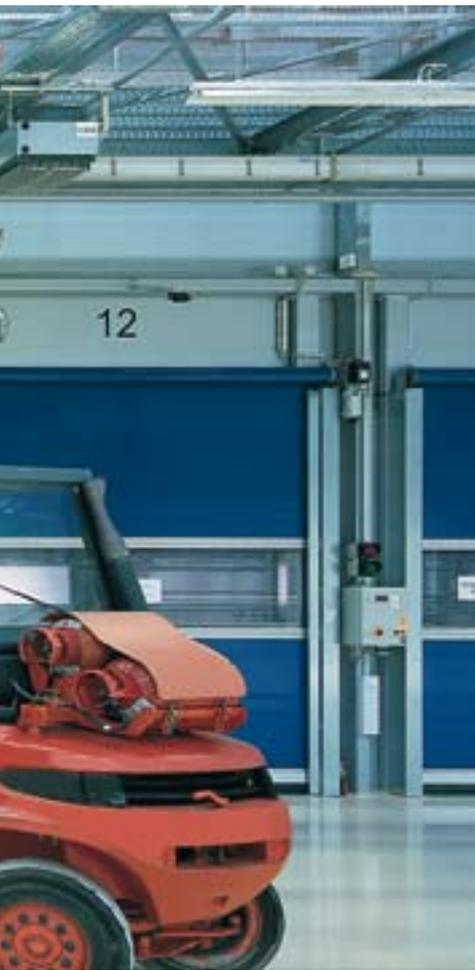
Hörmann Schnellauftore werden im Innenbereich und als Außenabschluss zur Optimierung des Verkehrsflusses, zur Verbesserung des Raumklimas und zur Energieeinsparung eingesetzt. Das Hörmann Programm umfasst vertikal und horizontal öffnende, transparente Tore mit flexiblem Behang sowie wärmedämmte Spiraltore. Durch die serienmäßige Ausstattung mit FU-Antrieb und Sicherheits-Lichtgitter sind alle Hörmann Schnellauftore besonders langlebig und servicefreundlich.
